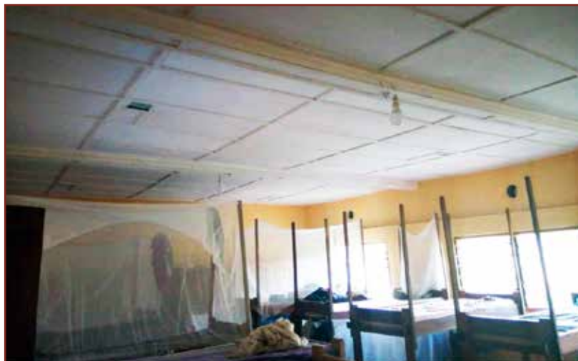
Im Jungenhostel wurde eine Decke, gegen die Wärme, eingezogen
