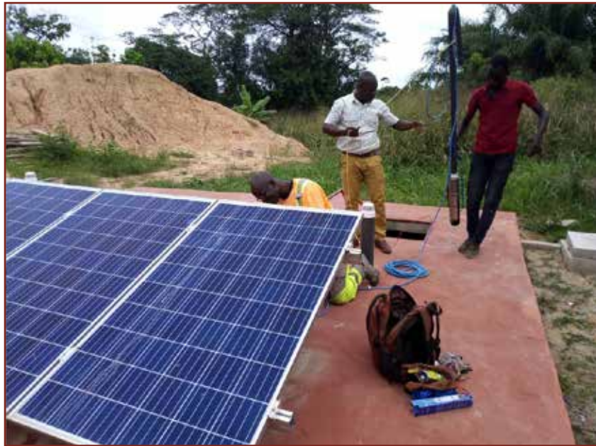
Alhaji und Isaac werden in die handhabung der Solarpumpe eingeführt.
