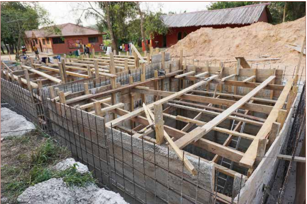
Der derzeitige Stand des Wasserreservoirs
